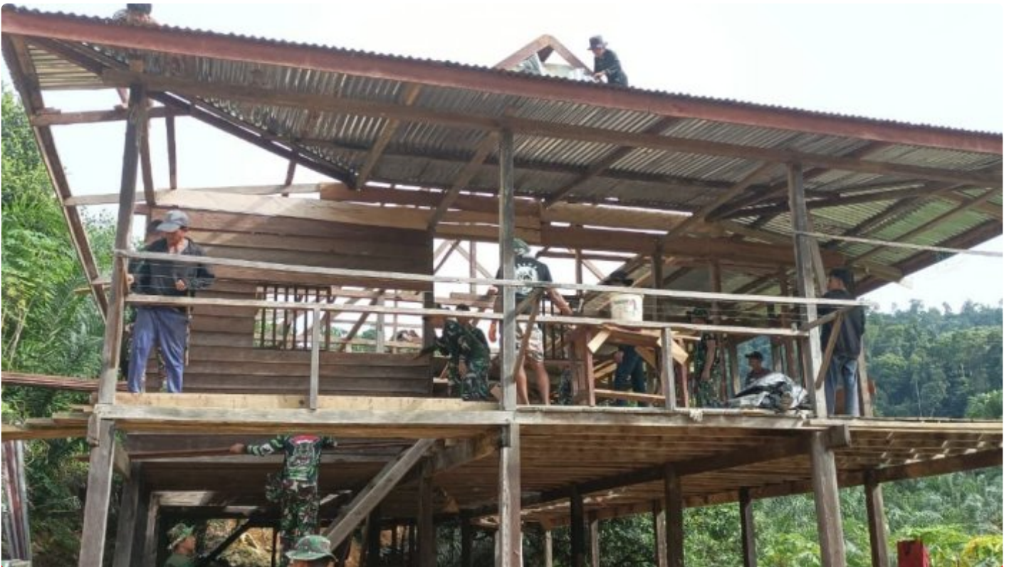
Foto Pembongkaran Rumah Warga
